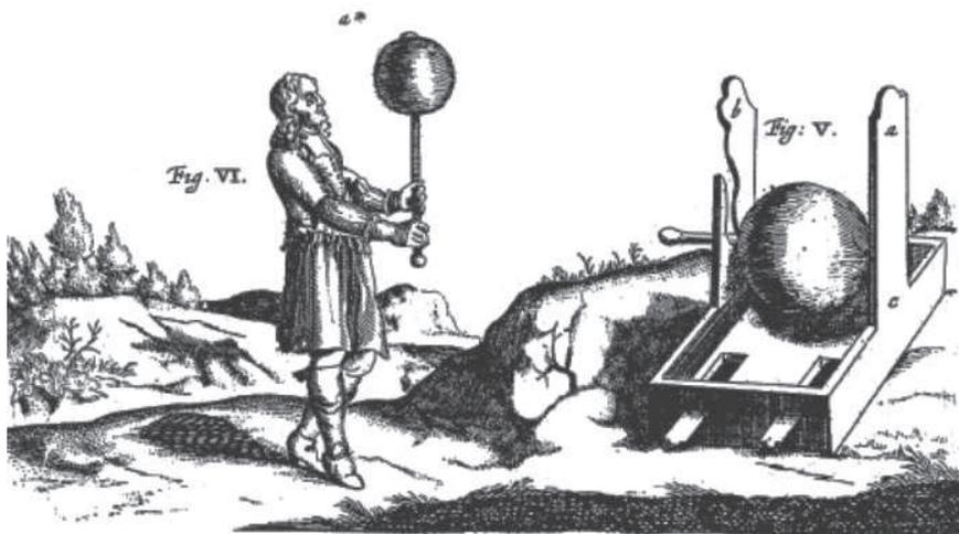
Figura 4.7. L'esperimento in cui Guericke faceva fluttuare una piuma sopra un globo di zolfo strofinato e, a fianco, la sua macchina elettrica.
